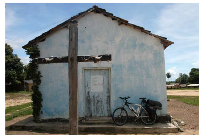
A pequena igreja remete à simplicidade da arquitetura local
